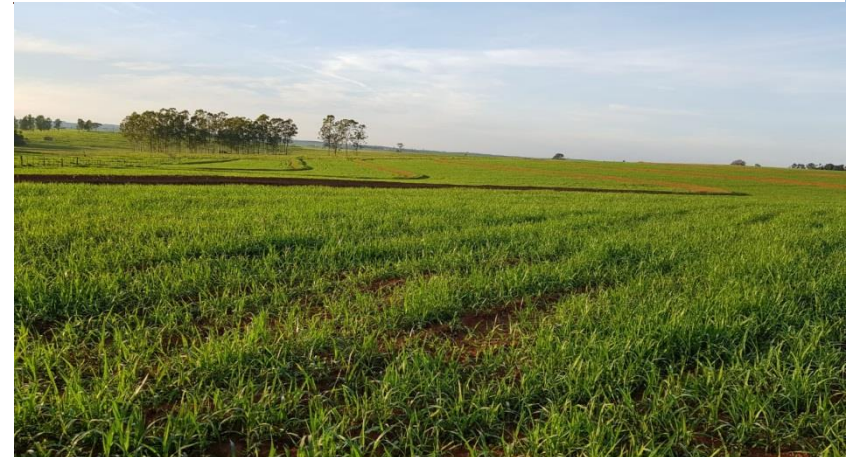
Construção de terraços em nível na área de contribuição hídrica
