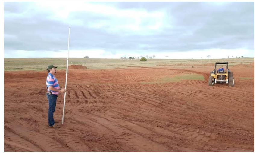
Locação e construção dos terraços
