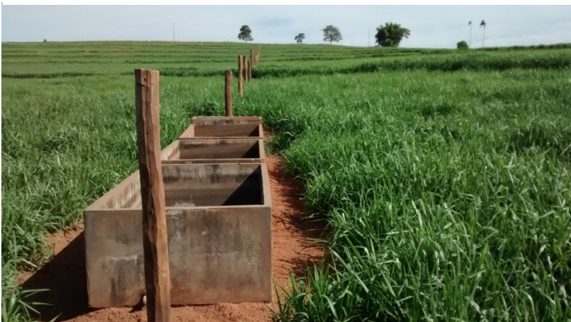
Construção de bebedouros e cercas
